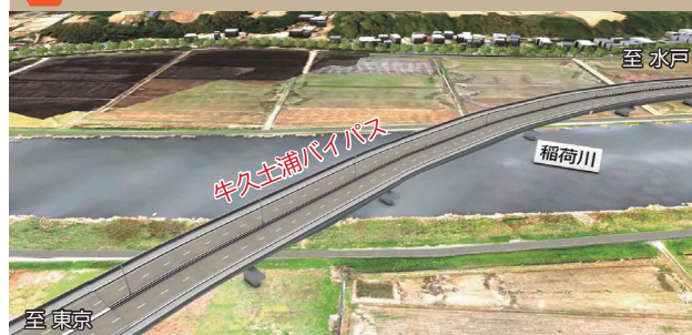
B 【橋梁区間】 稲荷川第1橋梁（仮称）
