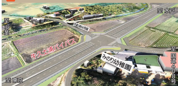
E 【盛土区間】 市道1級66号線付近
