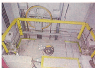
既存エレベーターシャフト内2
