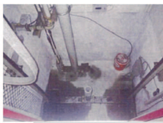
既存エレベーターシャフト内1
