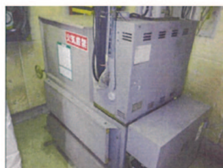
①既存油圧エレベーター機械室
