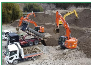
盛土材の振分けを行っています
