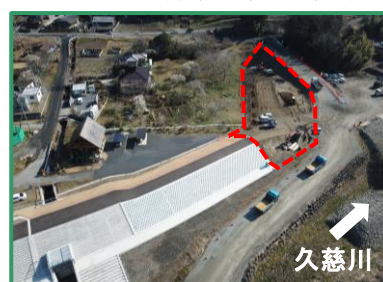
工事箇所の全景（上流から）
