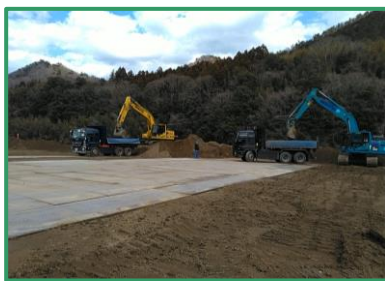
河道掘削を行っています
