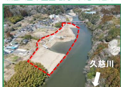
工事箇所の全景（下流から）
