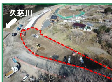
工事箇所の全景（下流から）
