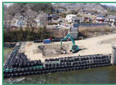
掘削作業を行っています
