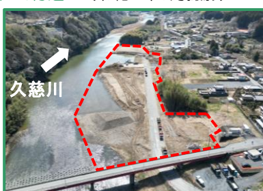
工事箇所の全景（上流から）
