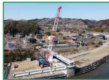
旧橋の撤去を行っています
