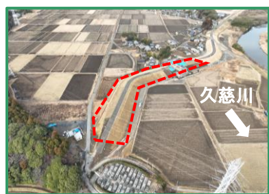
工事箇所の全景（下流から）
