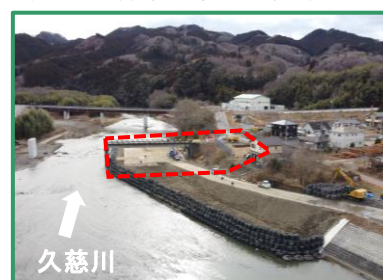
工事箇所の全景（上流から）
