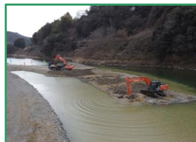
河道掘削を行っています
