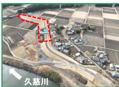
工事箇所の全景（上流から）
