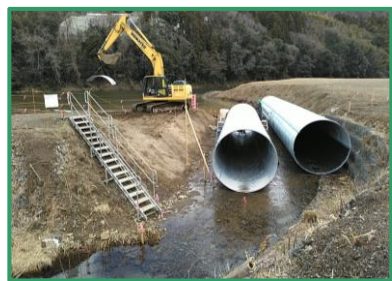
コルゲートの設置を行っています
