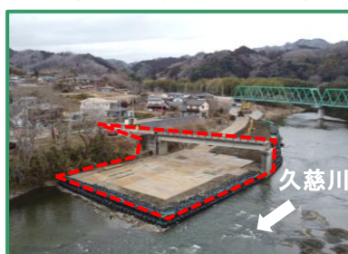
工事箇所の全景（下流から）
