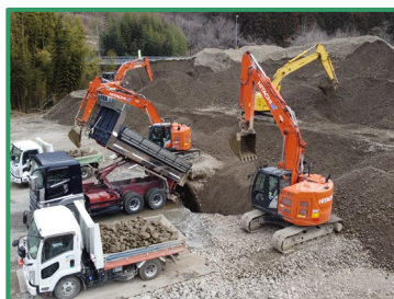
盛土材の振分けを行っています
