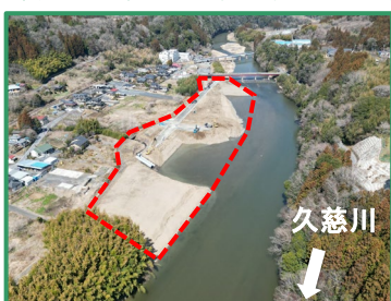
工事箇所の全景（下流から）
