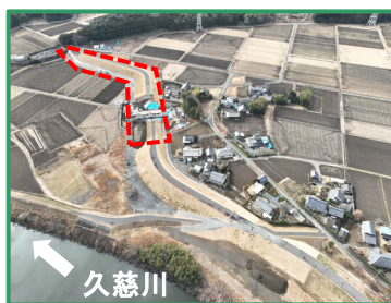
工事箇所の全景（上流から）
