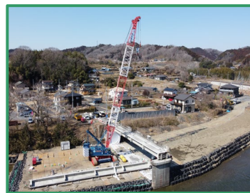
旧橋の撤去を行っています
