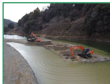
河道掘削を行っています
