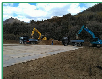
河道掘削を行っています
