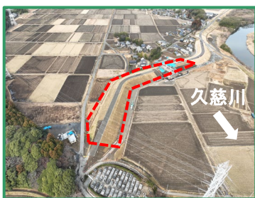
工事箇所の全景（下流から）
