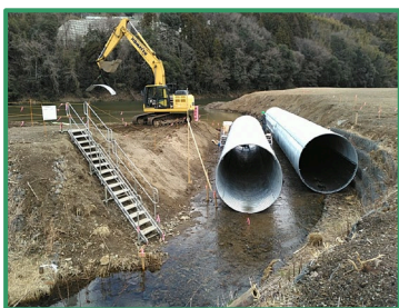
コルゲートの設置を行っています
