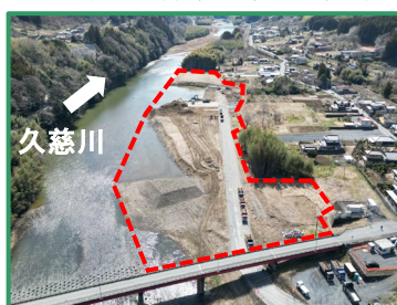
工事箇所の全景（上流から）
