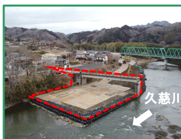
工事箇所の全景（下流から）
