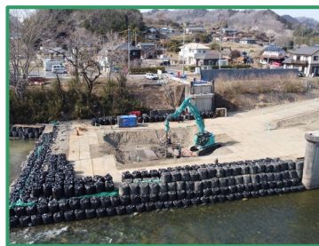
掘削作業を行っています
