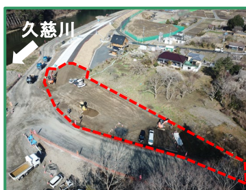
工事箇所の全景（下流から）
