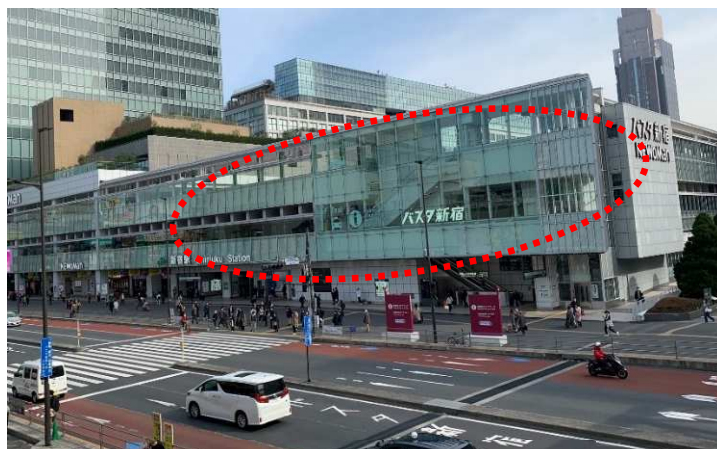
建物壁面への設置候補箇所
