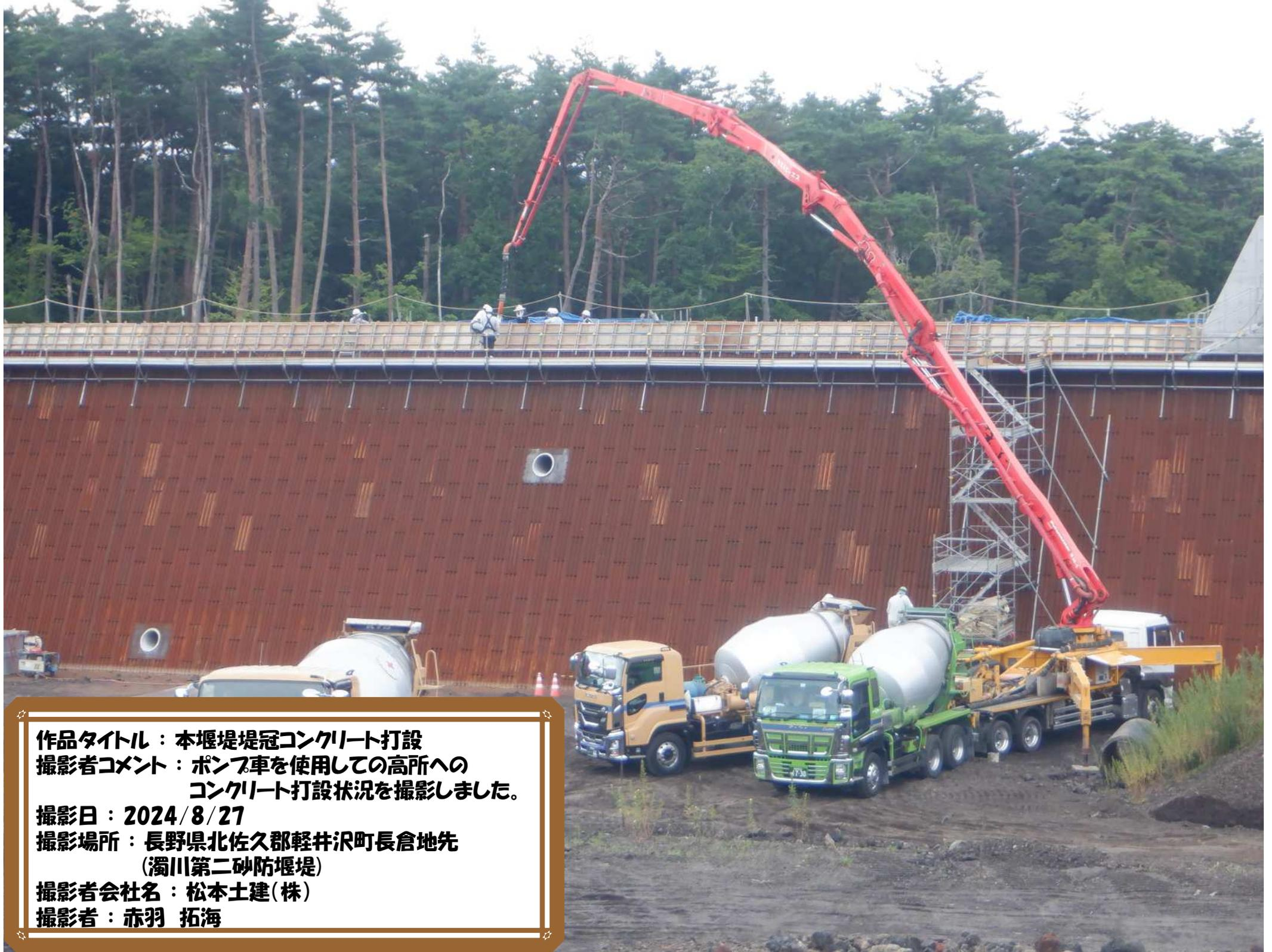
**作品タイトル：本堰堤堤冠コンクリート打設**
