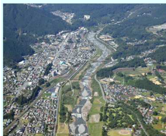
だいやがわ 大谷川床固工群
