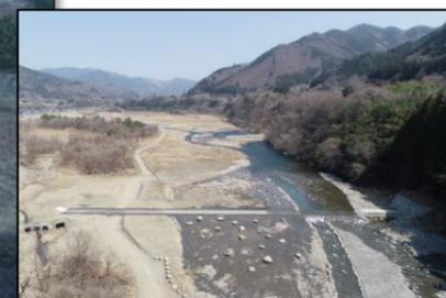
床固群（帯工）施工状況
