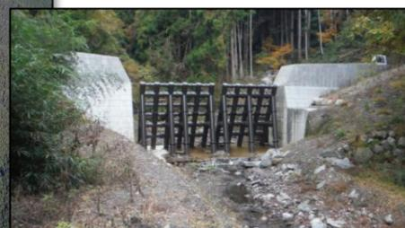
透過型砂防堰堤のイメージ
