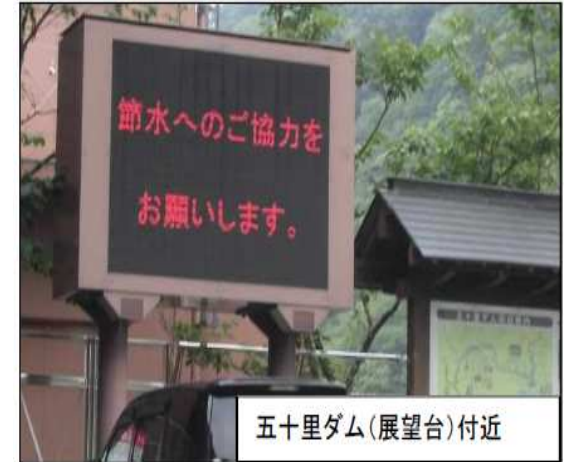
ダム放流警報表示板
