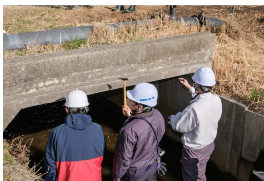
橋桁の健全性について打音検査で確認
