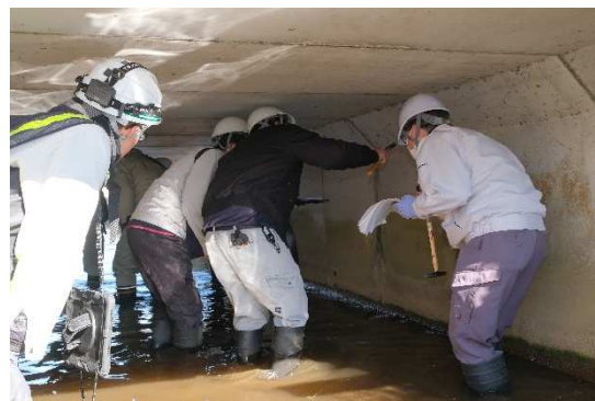
関東MC職員等により橋梁の下面などの点検ポイントについて説明
