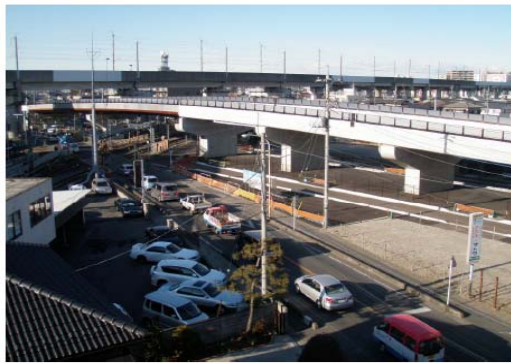
久喜跨線橋整備状況
