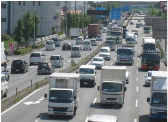
1位: 国道16号(新大宮バイパス重複区間) (さいたま市西区内野本郷地先)
