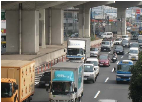
2位: 国道17号新大宮バイパス (戸田市早瀬地先)
