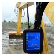
ICT建設機械の施工
