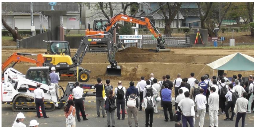
ICT施工現場体験会の開催状況
