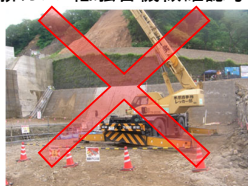
排ガス・低騒音機械確認写真
