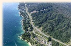
三陸沿岸道路（岩手県山田町）
