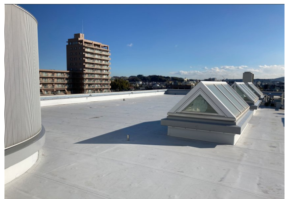
屋上防水工事
