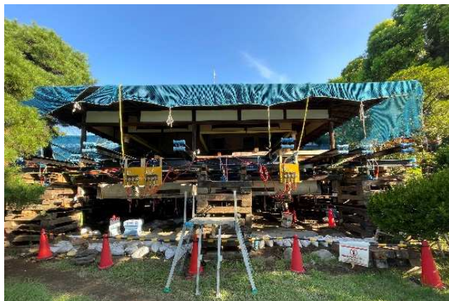
基礎補強等のためのあげや工事状況
