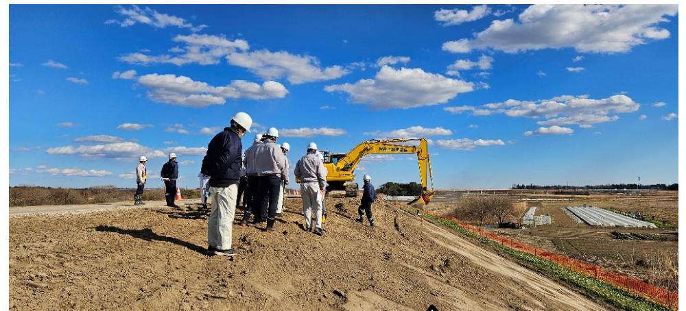
ICTバックホウによる 法面整形
