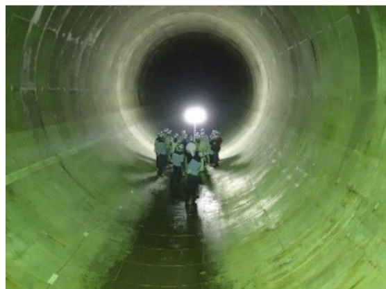
雨水貯留管の整備
