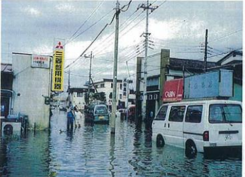
平成3年9月洪水による被害 (越谷市)
