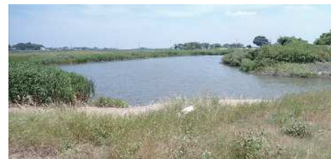
堤防を開削し静穏な水辺を再生
