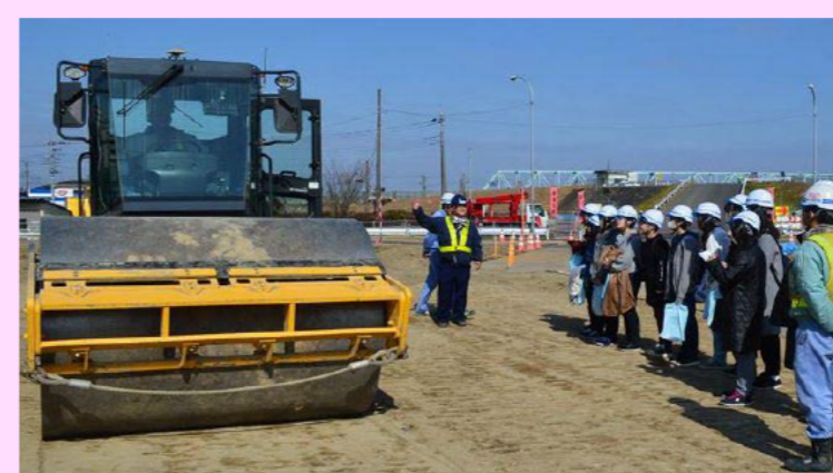
GNSSを用いた締固め管理
