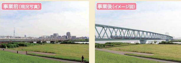
河川内の橋脚が2基で、鉄道のトラス橋としては国内最大径間長(193m)となり、河川への影響を最小限とします。
