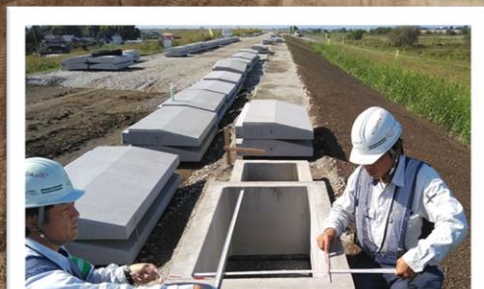
コンクリート2次製品の材料確認
