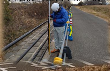
転落防止柵出来形確認
