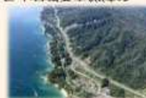
三陸沿岸道路（岩手県山田町）
