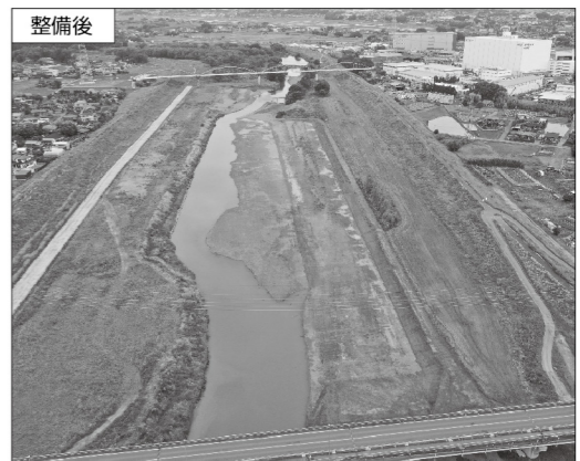
河道掘削・樹木伐採(越辺川 天神橋上流)
