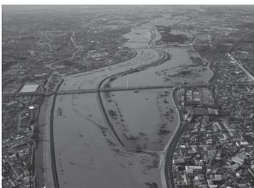
公園などが整備されている荒川第一調節池は、一時的に洪水をためて下流に流れる水の量を減らします。(2019年10月13日撮影)
