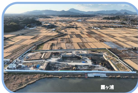
高浜機場の工事現場
