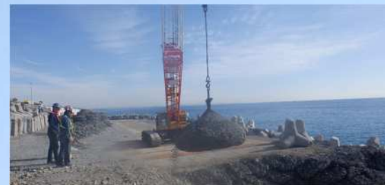
8トン袋詰玉石据付
