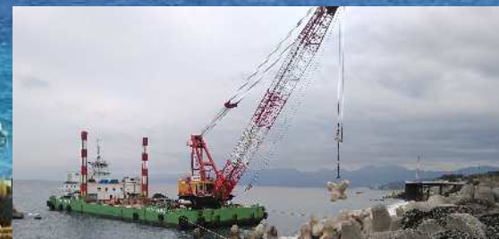
20トン消波ブロック据付
