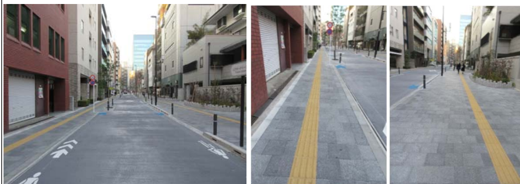
透水性舗装 整備状況写真
