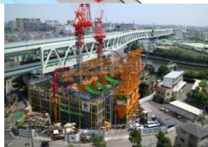
王子第二ポンプ所 (北区堀船、東十条)
