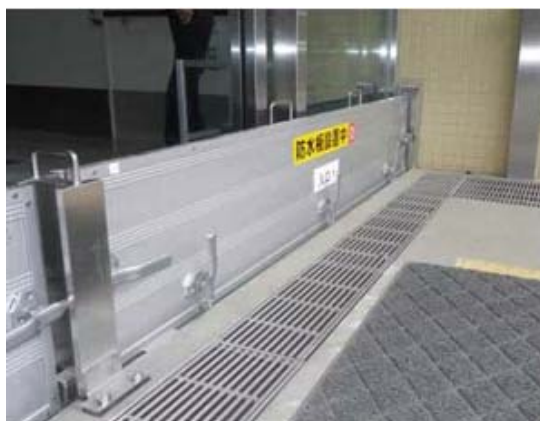
止水板設置状況写真
