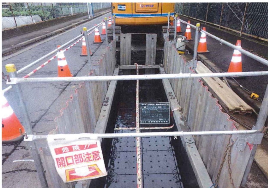
西東京市芝久保町四丁目地内 雨水対策工事施工状況
