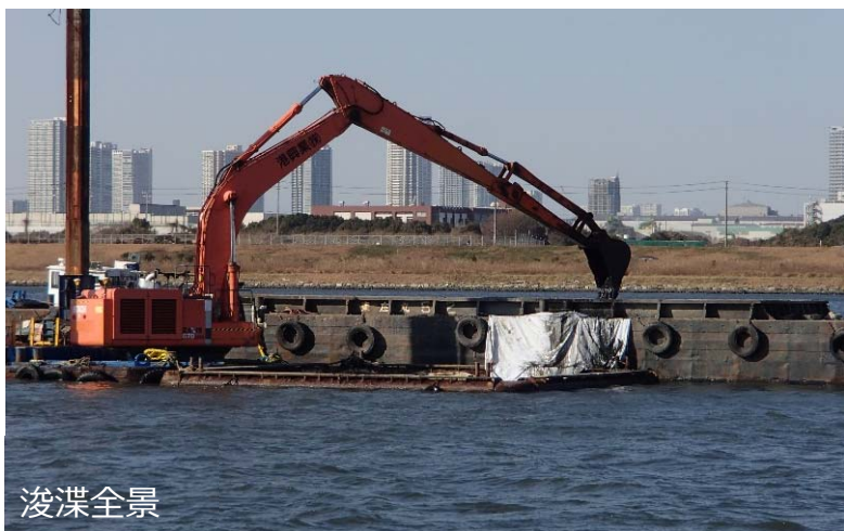
浚渫の実施状況
