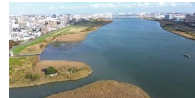
多摩川下流部(4.2kp付近)
