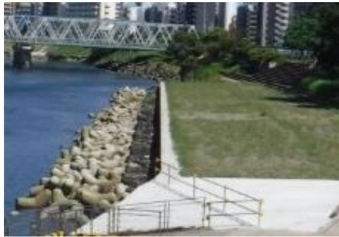
矢板護岸前面に根固めブロック及び詰め根固めを設置(多摩川)
