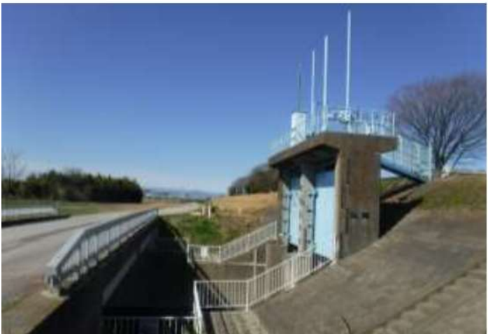
調布排水樋管
