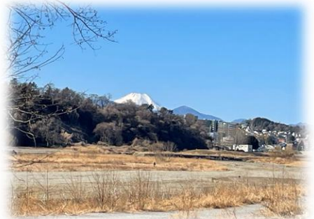
大丸用水堰の改築工事も終盤、冬の青空に富士山が映える冬の多摩川。春はもうすぐ？(250223 撮)
