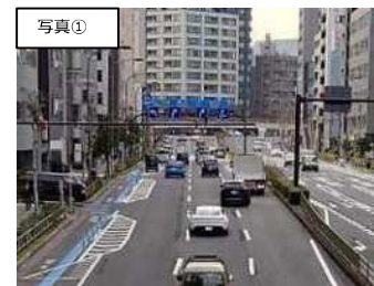
自転車専用通行帯ラバーポール
