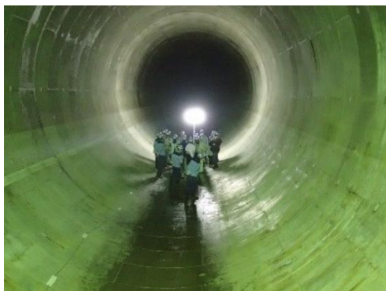
雨水貯留管の整備
