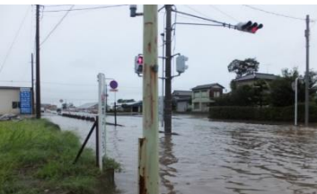
平成27年9月関東・東北豪雨による被害 (久喜市)
