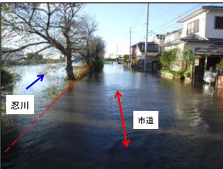
令和元年10月令和元年東日本台風による被害 (行田市)
