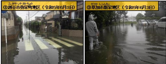
令和5年6月台風第2号による被害
