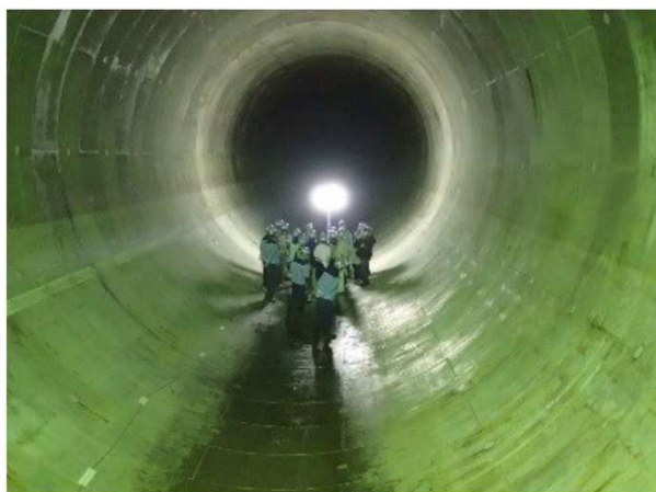
雨水貯留管の整備
