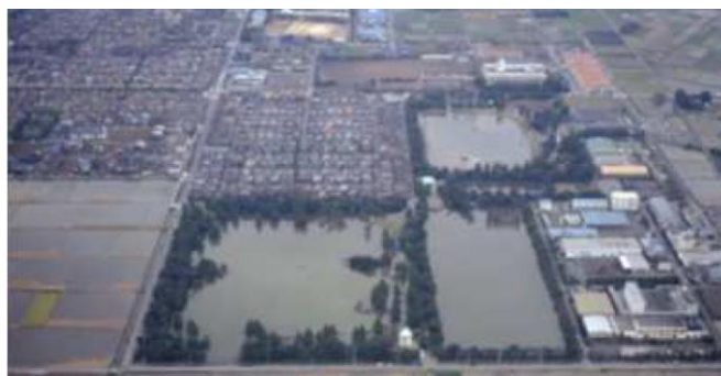
開発に伴う流出抑制対策（松伏調整池）
