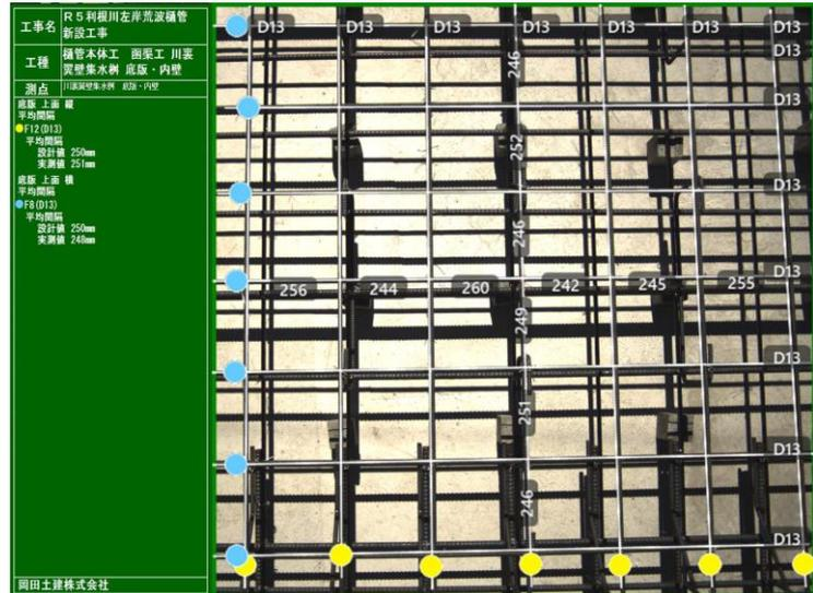
専用タブレットで撮影し、画面上で鉄筋を指定すれば、鉄筋径、間隔が自動表示され、出来形管理図表まで自動作成される
