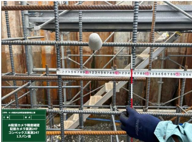
従来は検査する鉄筋にテープでマーキングし、1箇所毎にコンバックス、ノギスで確認
