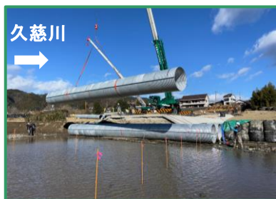
渡河施設を設置しています
