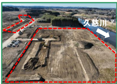
工事箇所の全景（下流から）
