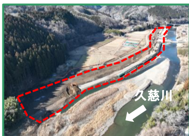
工事箇所の全景（下流から）
