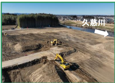
河道掘削を行っています
