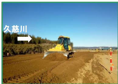
堤防盛土を行っています
