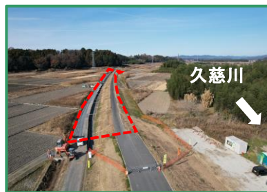
工事箇所の全景（下流から）
