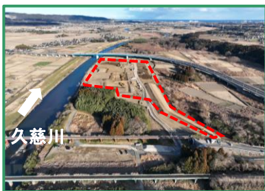
工事箇所の全景（上流から）
