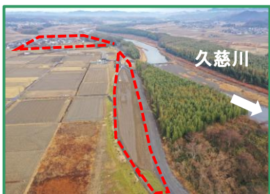
工事箇所の全景（下流から）
