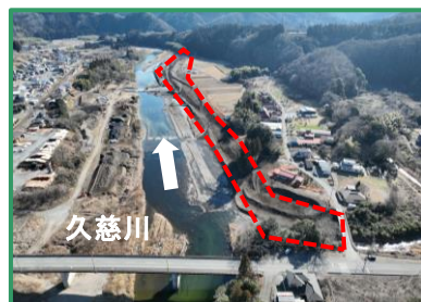
工事箇所の全景（上流から）
