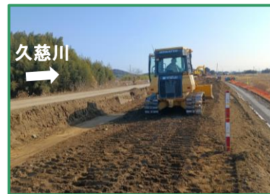
堤防盛土を行っています
