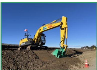
堤防盛土を行っています
