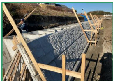
ブロック積みを行っています
