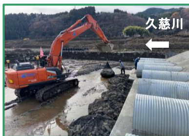
渡河施設を設置しています
