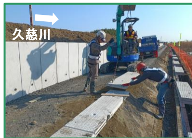
被覆ブロックを設置しています
