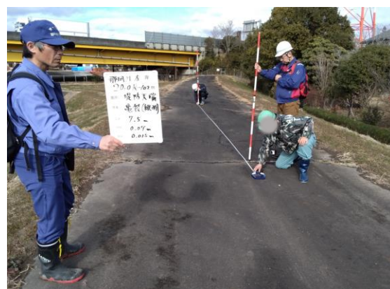
堤防の亀裂を測定する様子
