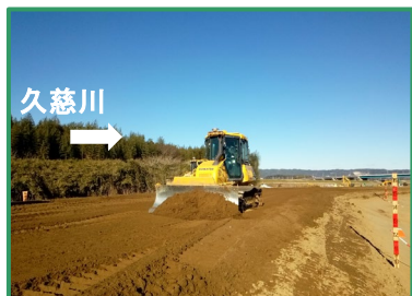
堤防盛土を行っています
