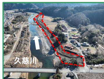
工事箇所の全景（上流から）
