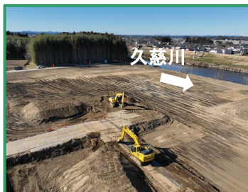
河道掘削を行っています
