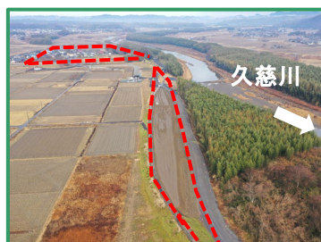
工事箇所の全景（下流から）
