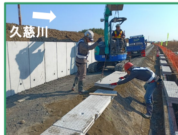
被覆ブロックを設置しています
