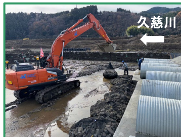
渡河施設を設置しています
