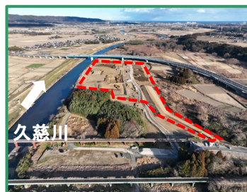
工事箇所の全景（上流から）
