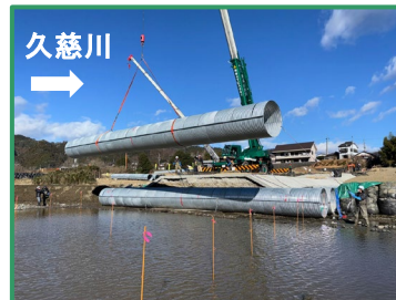
渡河施設を設置しています
