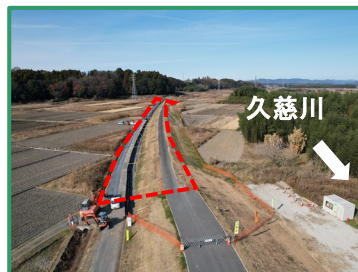
工事箇所の全景（下流から）
