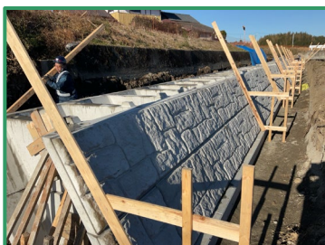
ブロック積みを行っています
