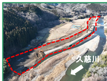
工事箇所の全景（下流から）
