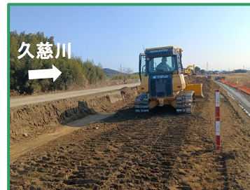
堤防盛土を行っています
