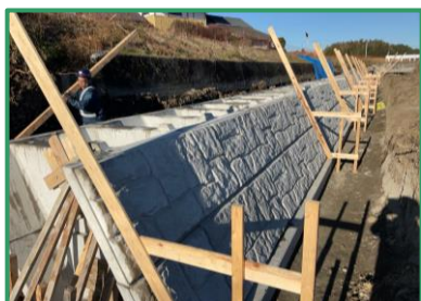
ブロック積みを行っています
