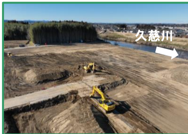
河道掘削を行っています
