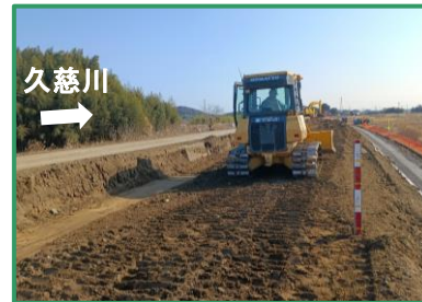
堤防盛土を行っています
