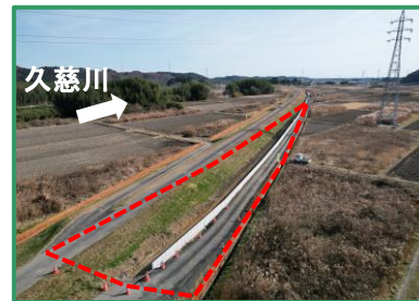
工事箇所の全景（上流から）
