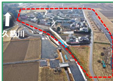
工事箇所の全景（上流から）
