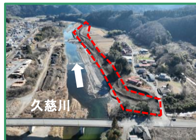
工事箇所の全景（上流から）
