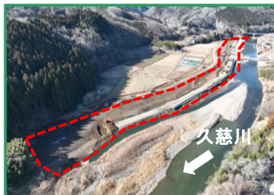
工事箇所の全景（下流から）
