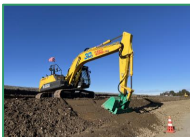
堤防盛土を行っています
