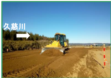
堤防盛土を行っています
