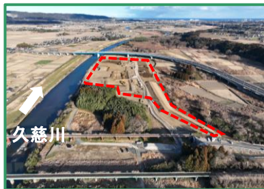
工事箇所の全景（上流から）
