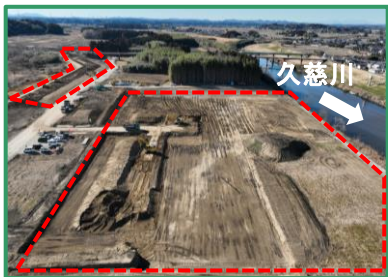
工事箇所の全景（下流から）
