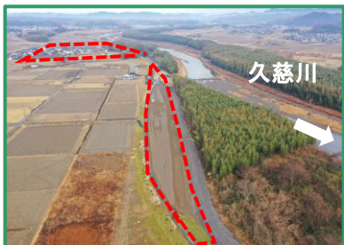
工事箇所の全景（下流から）
