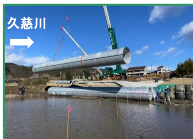
渡河施設を設置しています
