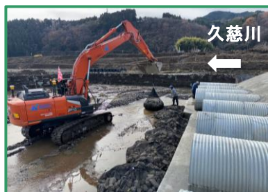
渡河施設を設置しています
