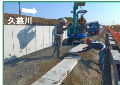
被覆ブロックを設置しています
