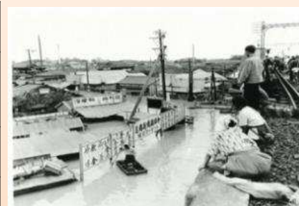
昭和22年 カスリーン台風 （葛飾区堀切橋付近） 利根川上流河川事務所HPより
