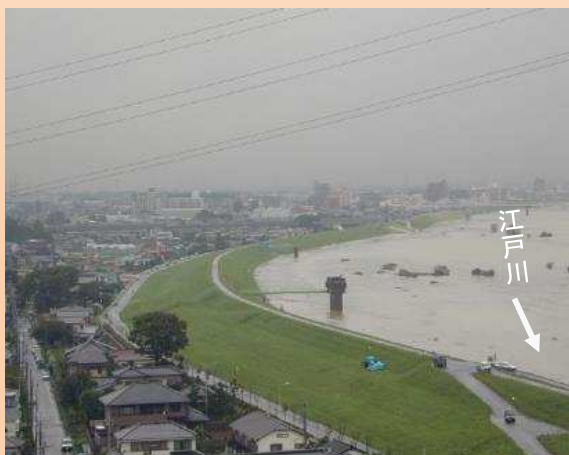
平成13年 台風15号出水状況 (24.5k付近)
