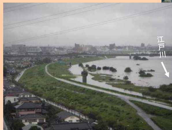
平成27年 台風17・18号出水状況 (24.5k付近)
