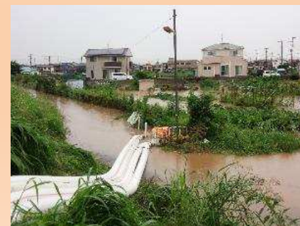
平成27年 台風18号 （松伏町河原地区での浸水状況）
