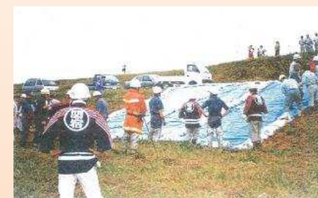
平成10年 台風5号 （江戸川左岸（現：野田市関宿元町）での堤防漏水）
