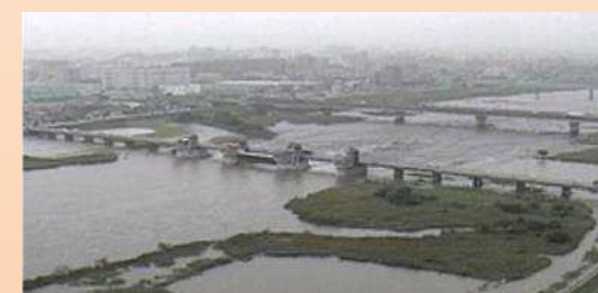
平成27年 台風18号 （洪水を流す行徳可動堰）
