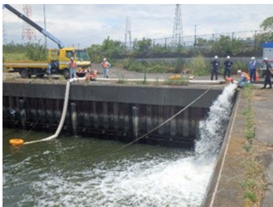
排水ポンプ車等操作講習会の実施
