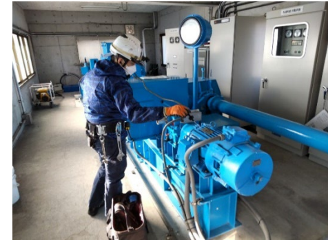
開閉装置の点検
