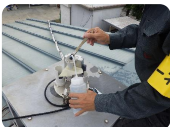
水文・水理観測機器の点検補修
