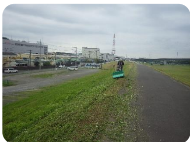
堤防の除草作業
