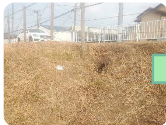
堤防の陥没の補修
