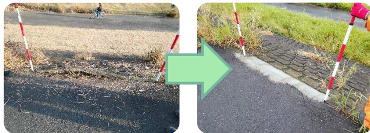
堤防の法肩の補修前後
