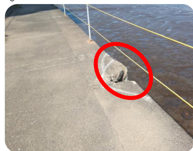
護岸の損傷
