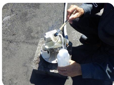
水文・水理観測機器の点検補修
