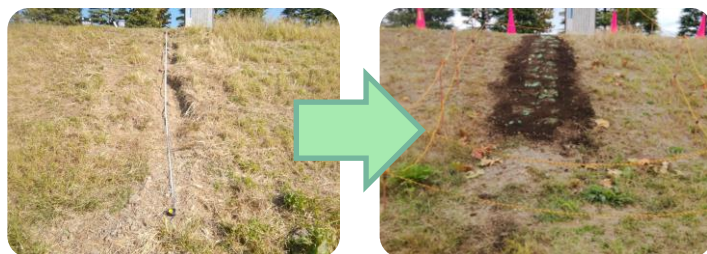
堤防の踏み荒らしの補修前後
