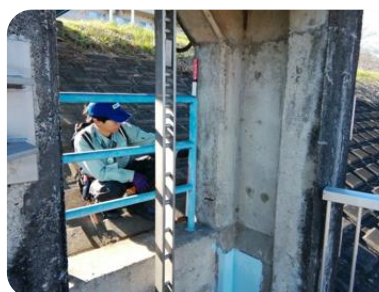
構造物点検実施の様子
