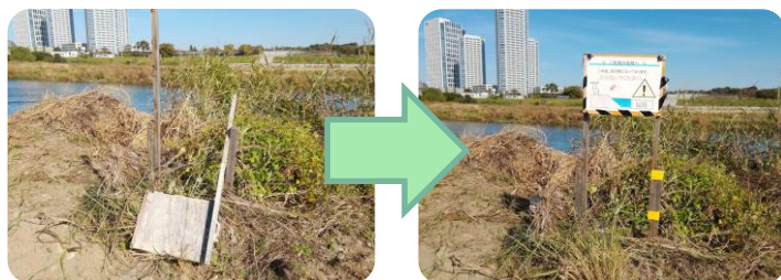
看板の仮補修前後
