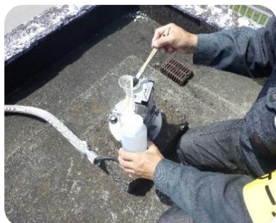
水文・水理観測機器の点検補修
