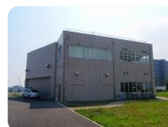
大師河原河川防災ステーション
