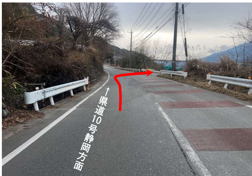
写真② （県道10号静岡側から坂路へ進入）
