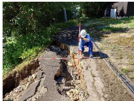
第2陣 被災状況調査
